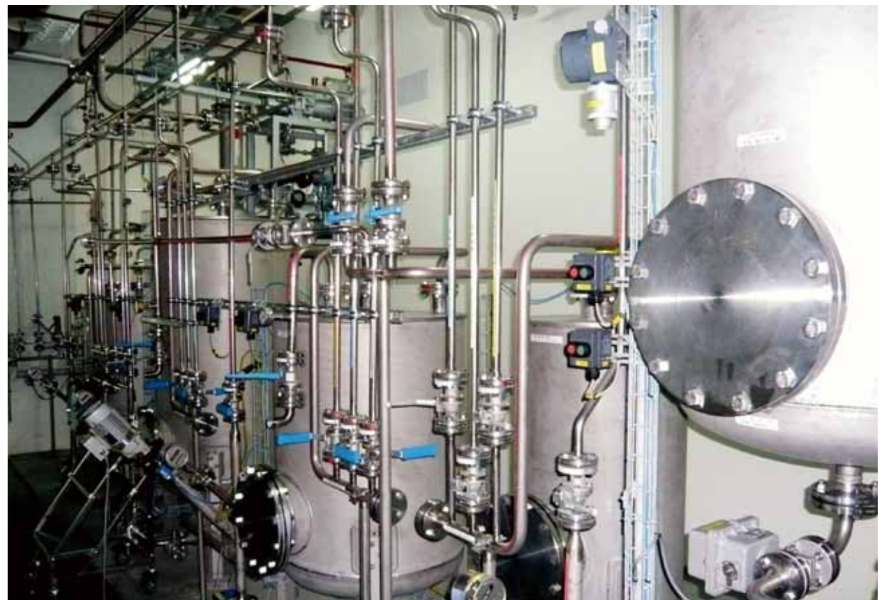
➤ 館方從德國引進除酸系統，徹底治療書籍脆化問題。（國立中央圖書館臺灣分館提供）
