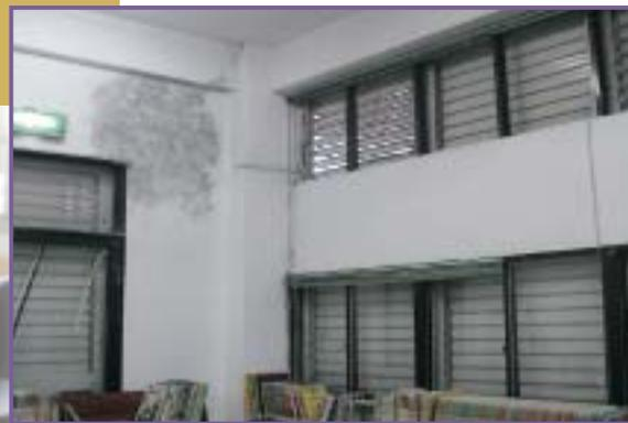
施工前油漆脫落、鋁門窗損壞無法打開
