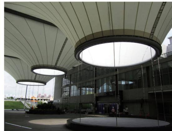
➤ 大東藝術圖書館的戶外廣場運用半透明漏斗型薄膜結構打造具流動性的戶外空間。
