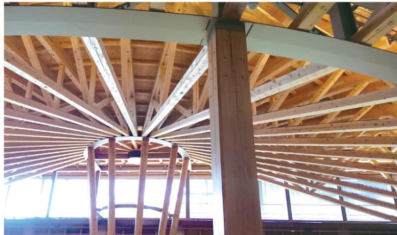
➤ AIU圖書館建築以「羅馬競技場」為主題，搭建出木造及鋼筋混凝土的複合式建築，用傳統技術的概念設計半圓傘狀屋頂，營造強烈的日式氣氛。
