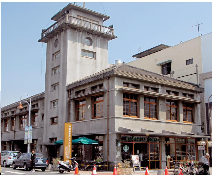
◀ 1939年所建的合作廳舍為鋼筋混凝土加強磚造的二層樓建築。
