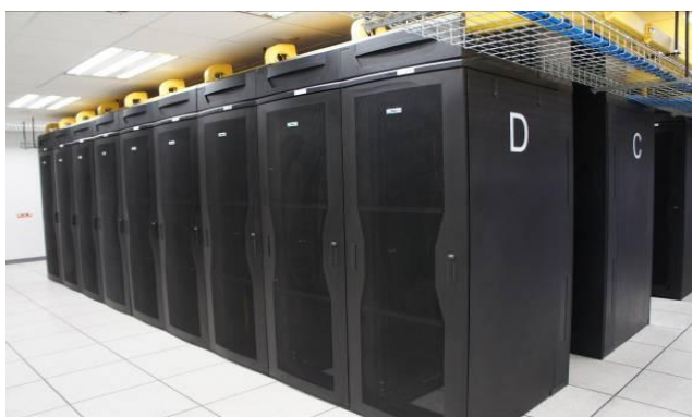
圖 179 綠能機房—熱通道煙囪型機櫃
