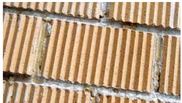
鹿草鄉立圖書館外牆由具有閃避雷達偵測的十三溝面磚構成。
