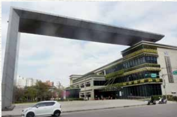
▲ 桃園市立圖書館中壢分館以巨大的門型衍架展現迎賓氣象，大量的玻璃帷幕搭配耐生植物的綠牆吸引行人的目光。
