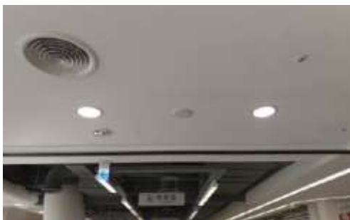
圖 180 崁頂喇叭安裝完成
