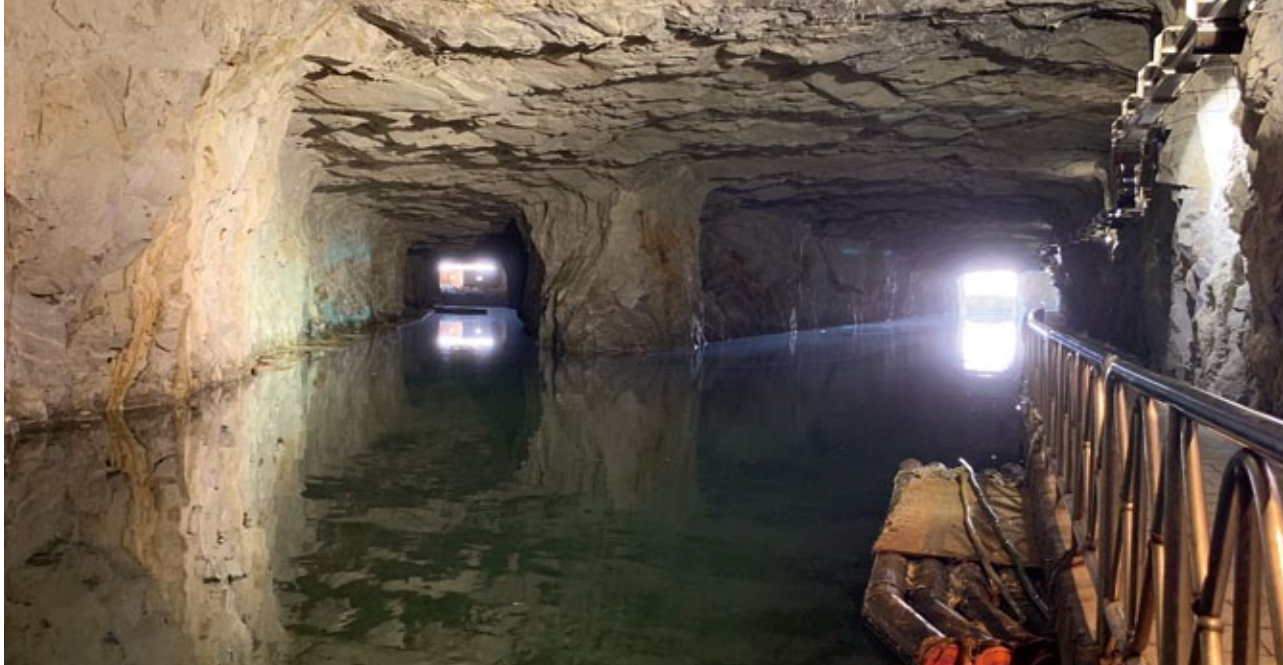
▲ 翟山坑道為登陸小艇搶灘運補之用。
