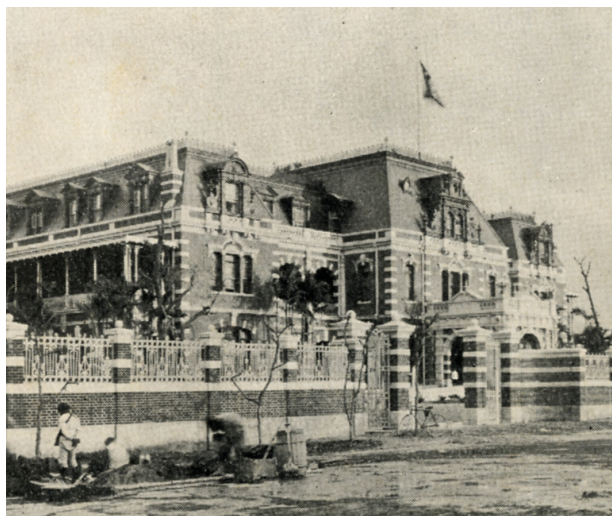
建地620多坪的臺灣鐵道旅館
