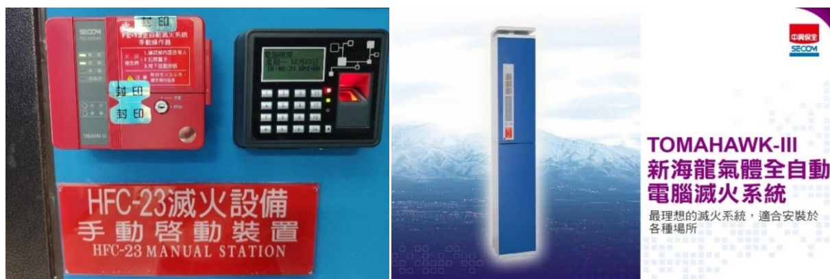
圖 126 HFC-23 新海龍氣體全自動滅火系統
