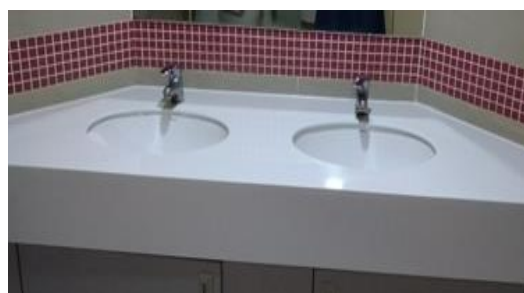
圖 253 廁所洗手台人造石鋪面
