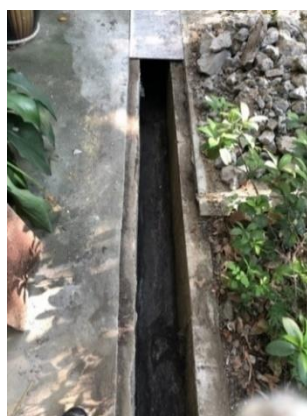
圖 251 陰井、排水管道疏通
