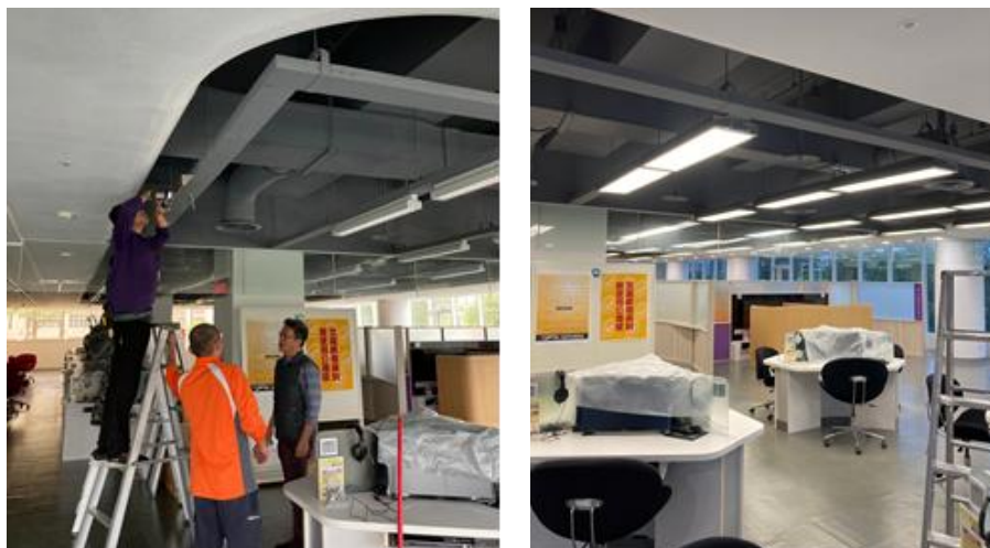
圖 227 汰換 2 樓視聽欣賞區格柵型燈具為 LED 平板型燈
