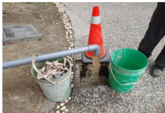
圖 230 鑿井完成進行洗井
