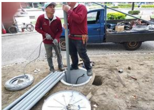
圖 229 鑿井工程沉水馬達配電、配管
