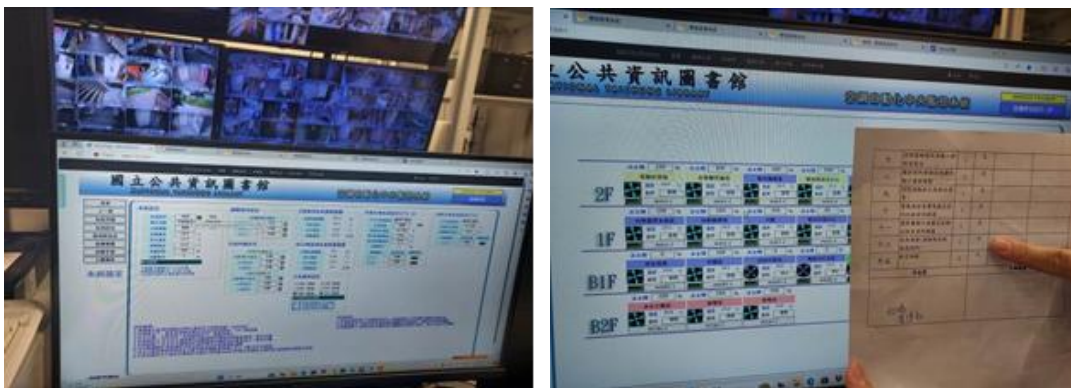
圖 228 機水電監控系統設備升級
