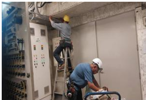
圖 231 電盤及多迴路電錶管路佈線
