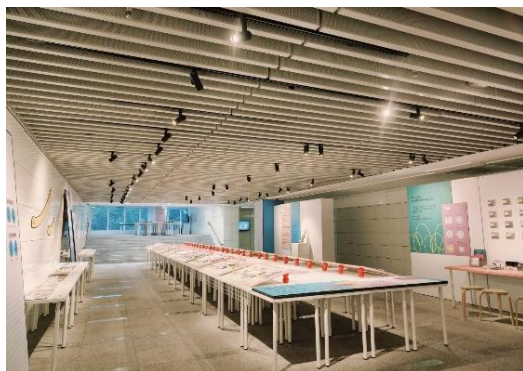
圖 170 汰換 2 樓藝文走廊投射燈
