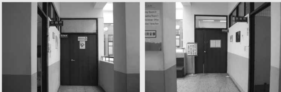
各樓層中庭兩邊都設有廁所和通道
