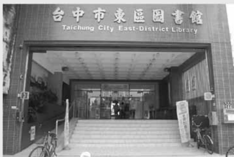
無障礙坡道直衝馬路
