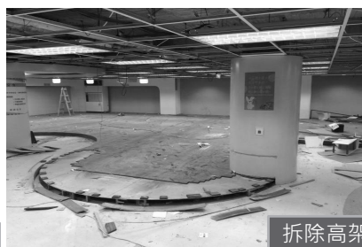
B1地板工程
