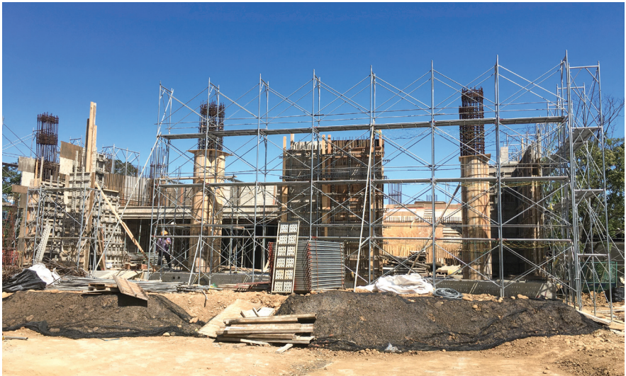
圖2 本案啟動時建築工程施工進度（事務所拍攝）
