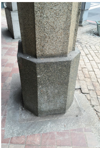
圖21 入口門柱的「底几帳面」轉角處理
