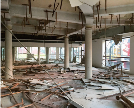
圖15 拆除天花板後露出精緻的格子梁天花板
