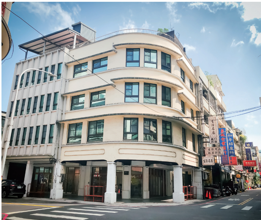
圖11 位於大同路與中央路交叉口的108再生基地
