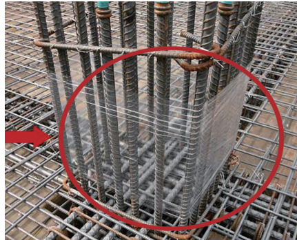
圖8 混凝土澆築前以塑膠膜保護避免鋼筋被混凝土污染
