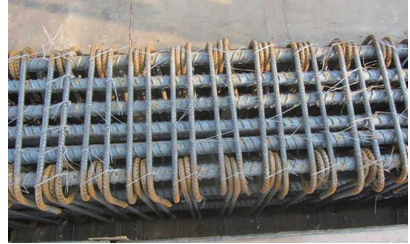
圖10 梁箍筋綁紮間距控制良好
