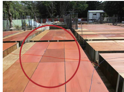
圖23 模板規劃良好對縫對線且鋼筋綁紮前清除乾淨無灰塵
