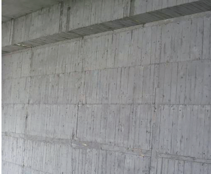
圖5 混凝土澆築控制良好，完成面平整
