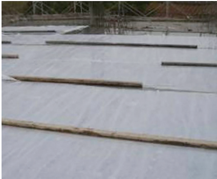
圖7 混凝土澆築完成進行養護
