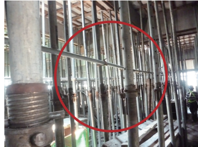
圖21 鋼管支撐有用水平繫條連結且使用制式插銷
