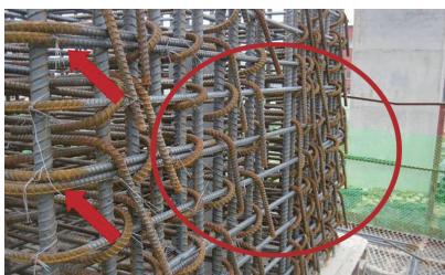
圖15 繫筋勾在箍筋上不符規定應勾在主筋上
