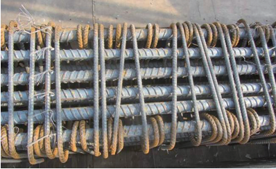
圖9 梁箍筋綁紮間距不一致
