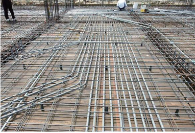
圖18 管路佈設良好符合規定
