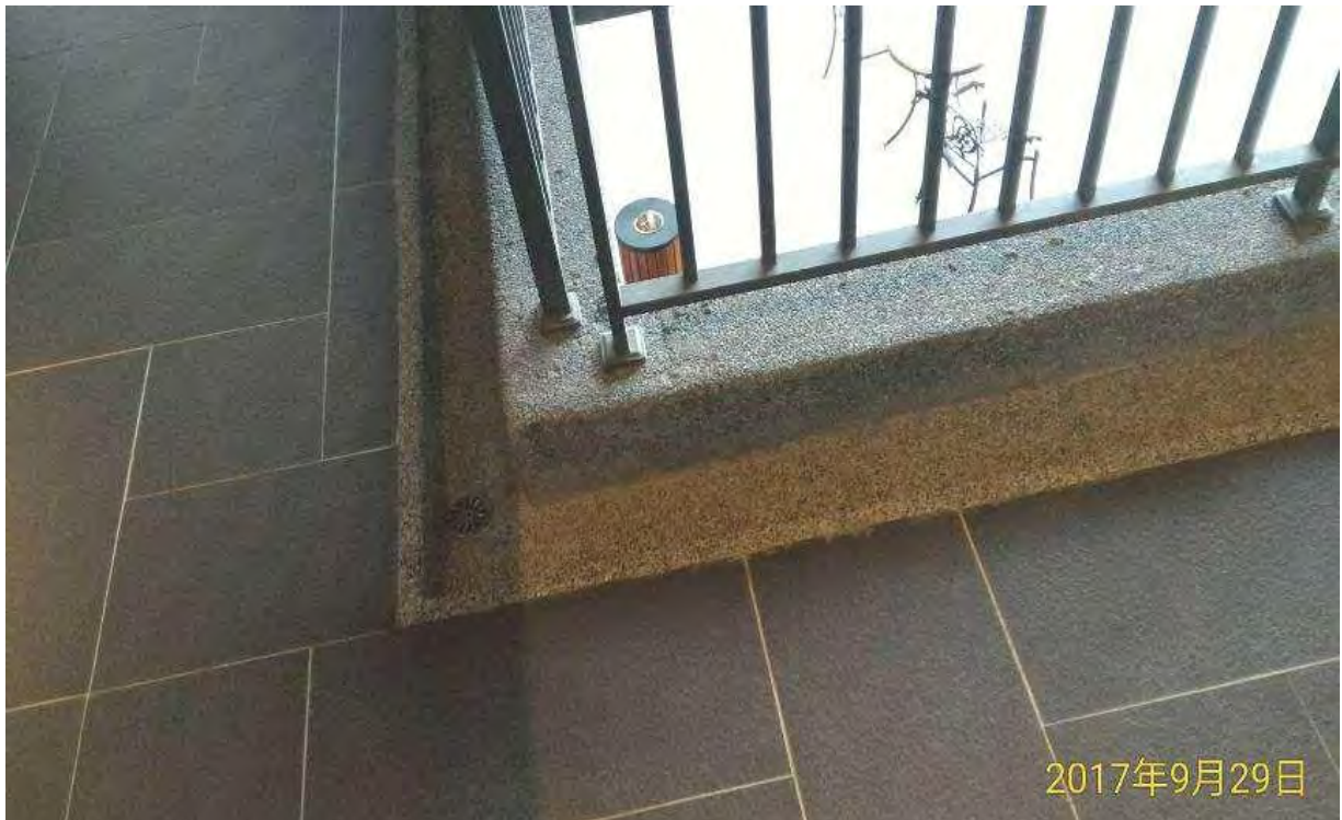
走廊地坪事先考量導水溝之實例
