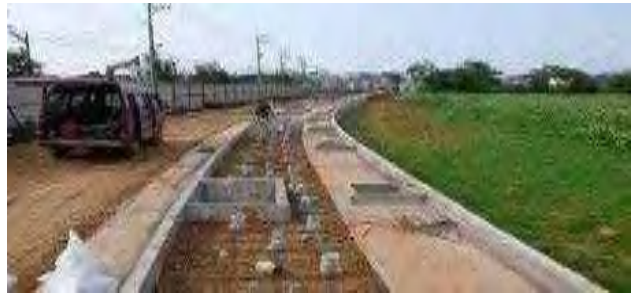
高壓混凝土磚以硬底施工加PVC管透水優良案例
