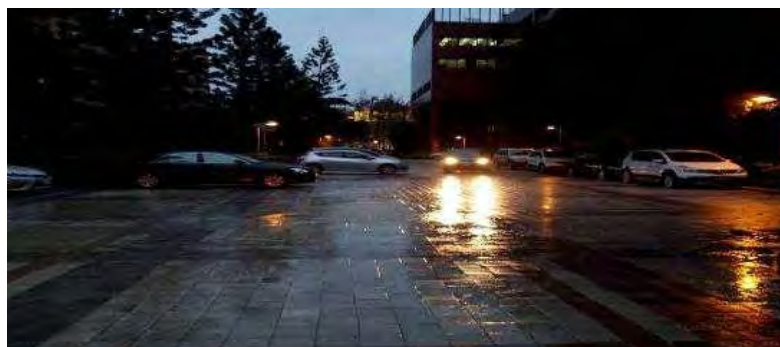
營建署高壓混凝土磚遇雨無法透水反而造成冒水泥滯岡境
