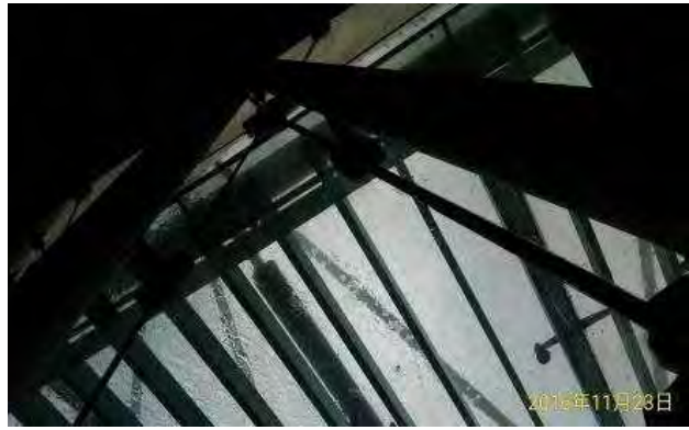
基隆新站弧形玻璃帷幕節點塞水路施工不良遇雨滲漏
