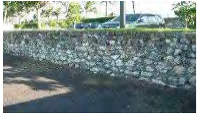
砌石擋土牆設置透水管立面
