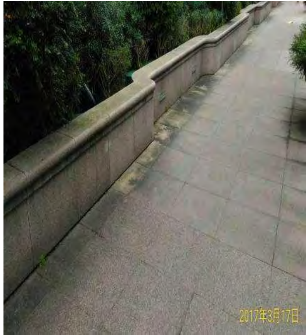
花台排水未考量截水溝水四處漫流污染鋪面實例
