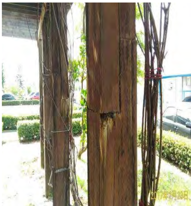
花架木構造使用錯誤的固定方式造成更易腐朽
