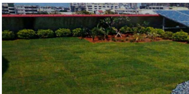
屋頂綠化直接靠女兒牆未留設清潔落水管空間
