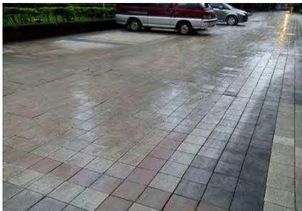
營建署高壓混凝土磚遇雨無法透水反而造成冒水泥滯岡境
