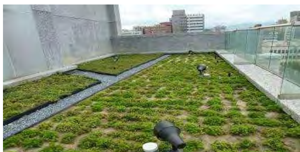
屋頂綠化直接靠女兒牆未留設清潔落水管空間
