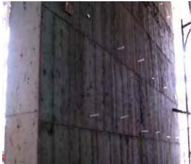
模板螺栓桿件加塑膠管之不當工法
