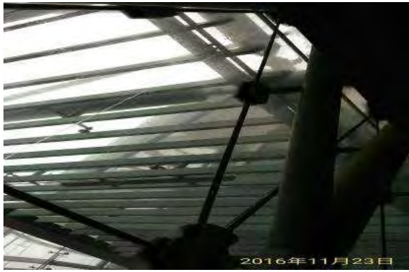
基隆新站弧形玻璃帷幕節點塞水路施工不良遇雨滲漏
