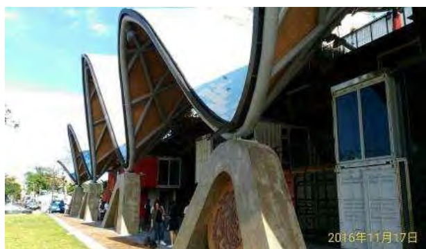
台東原住民會館弧形屋頂弧度不良雨水無法順著導溝經滴水排入地面陰井遇暴雨還有可能形成飛瀑群之奇觀
