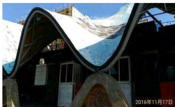
台東原住民會館弧形屋頂弧度不良雨水無法順著導溝經滴水排入地面陰井遇暴雨還有可能形成飛瀑群之奇觀
