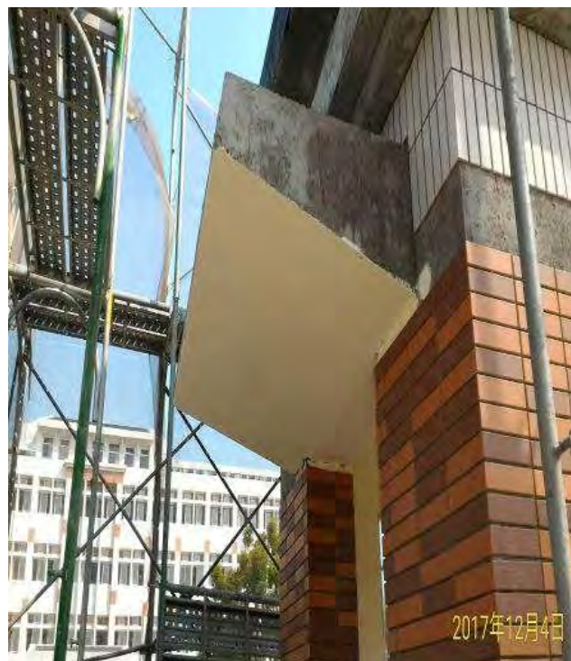
入口牆簷內斜未考量風雨會導致滲漏也無法以滴水線方式收頭之謬誤
