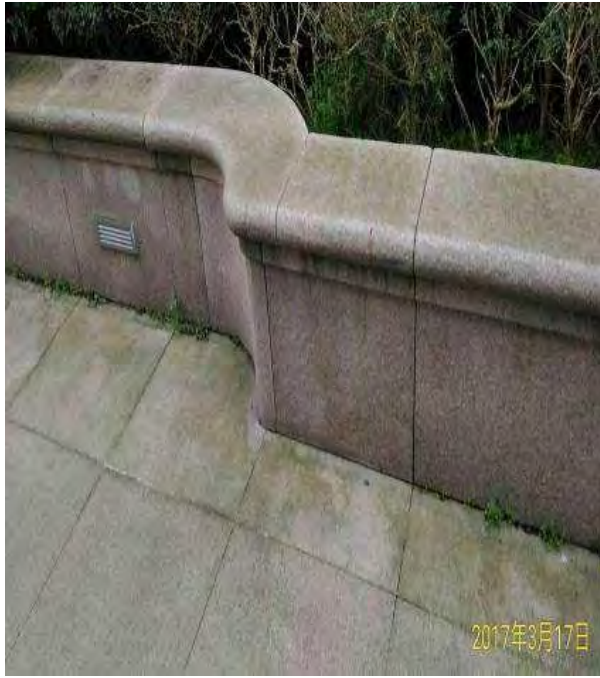
花台排水未考量截水溝水四處漫流污染鋪面實例
