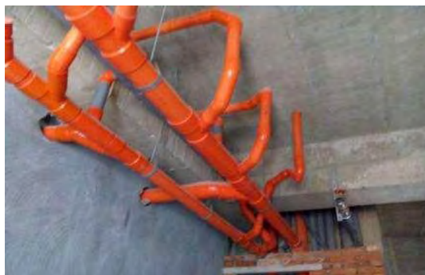
排水管由主幹管側邊30度順接工法
