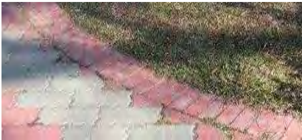
高壓混凝土地面磚周邊砌磚緣石優良做法
