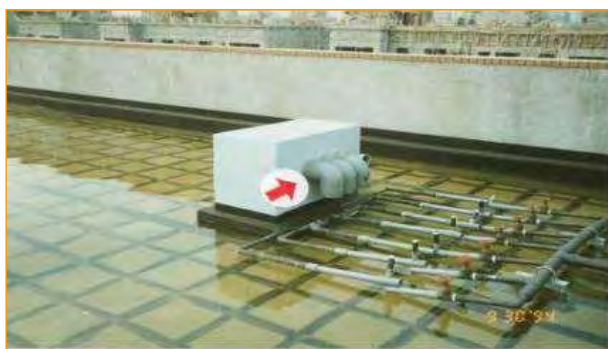
屋頂管道間管路透氣管應於泛水上方伸出管道間外
