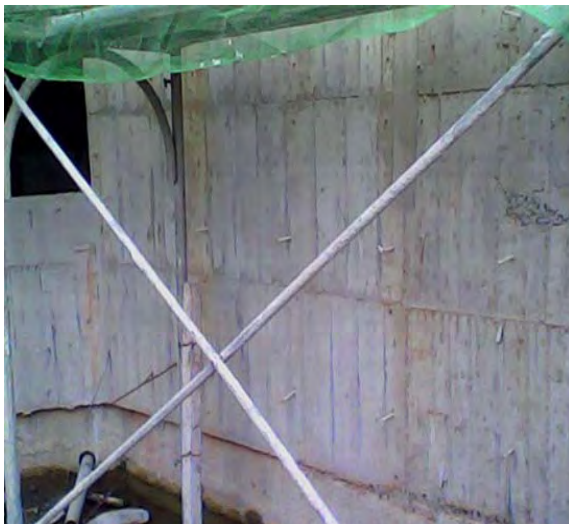
模板螺栓桿件加塑膠管之不當工法
