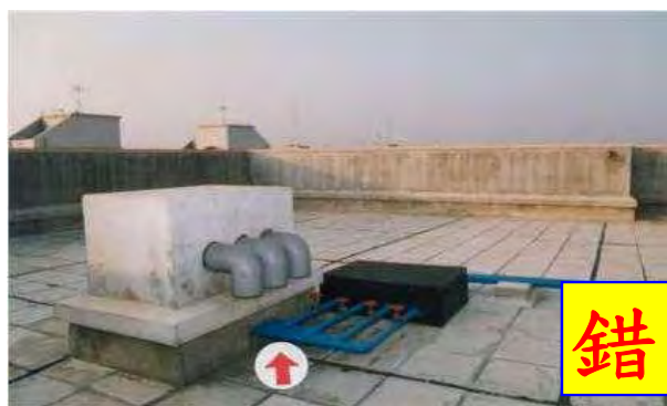
屋頂給水管應在泛水上穿入管道間（避免垂直面之防水層被破壞）
