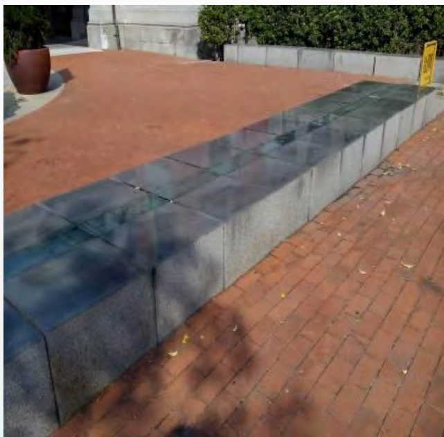
以石粉攪拌樹脂壓鑄或窯燒成型之仿石材料實體
