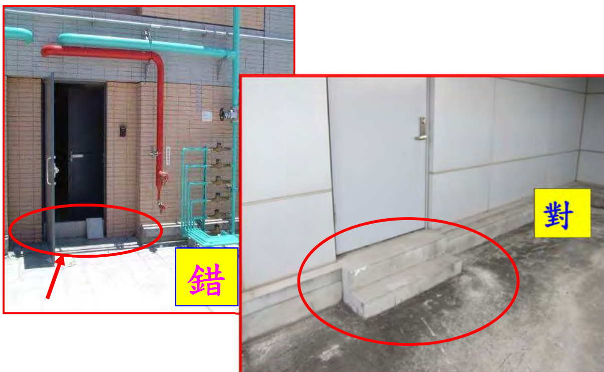
屋頂泛水應整體圍繞不得中斷(破口)
