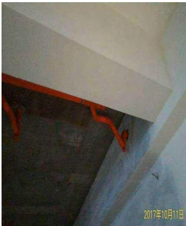
排水管低於主幹管向上銜接會導致逆流阻塞
