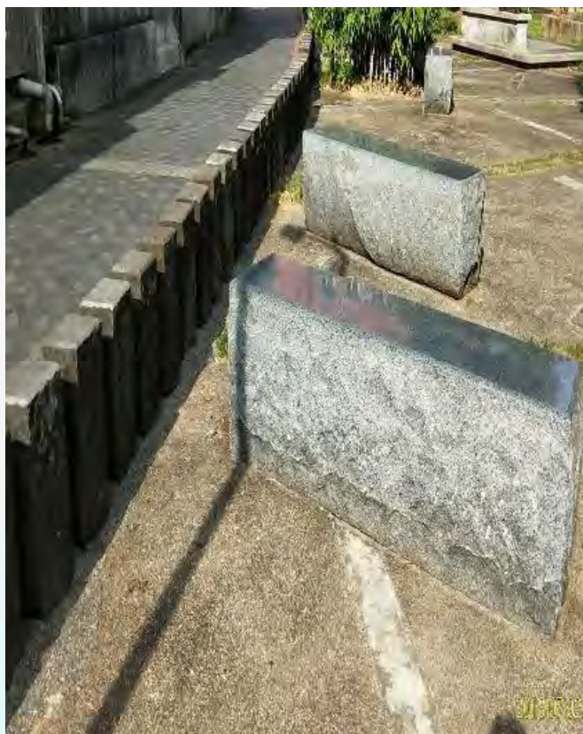
以石粉攪拌樹脂壓鑄或窯燒成型之仿石材料實體
