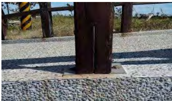
木構造欄杆正確的固定方式
