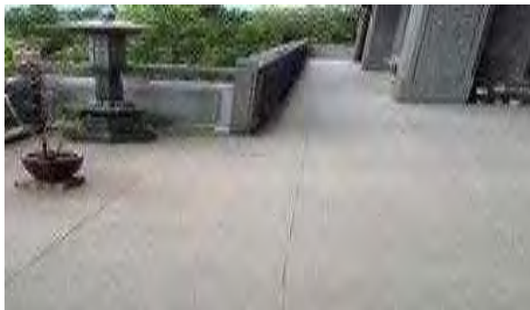
走廊地坪事先考量導水溝之實例
