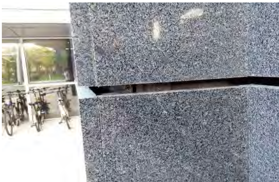
衛福部石材以無嵌縫施工法施工結構完成面以彈泥防水材料塗佈
