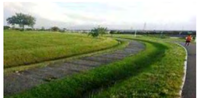
沿步道設置草溝排水實例
