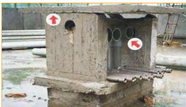
屋頂管道間管路透氣管應於泛水上方伸出管道間外
