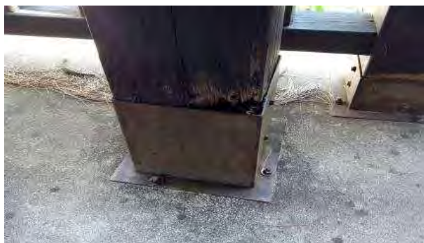
木構造使用錯誤的固定方式造成更易腐朽
