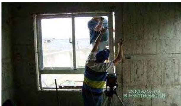
鋁窗周邊填塞砂漿空間
