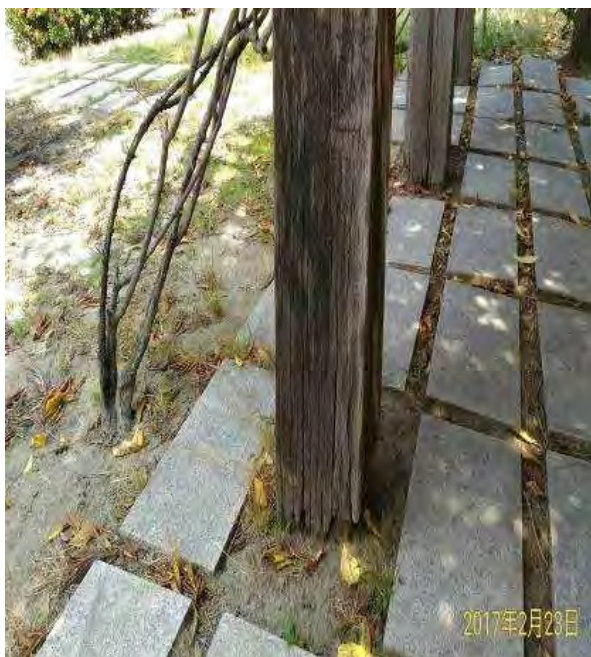
花架木構造使用錯誤的固定方式造成更易腐朽
