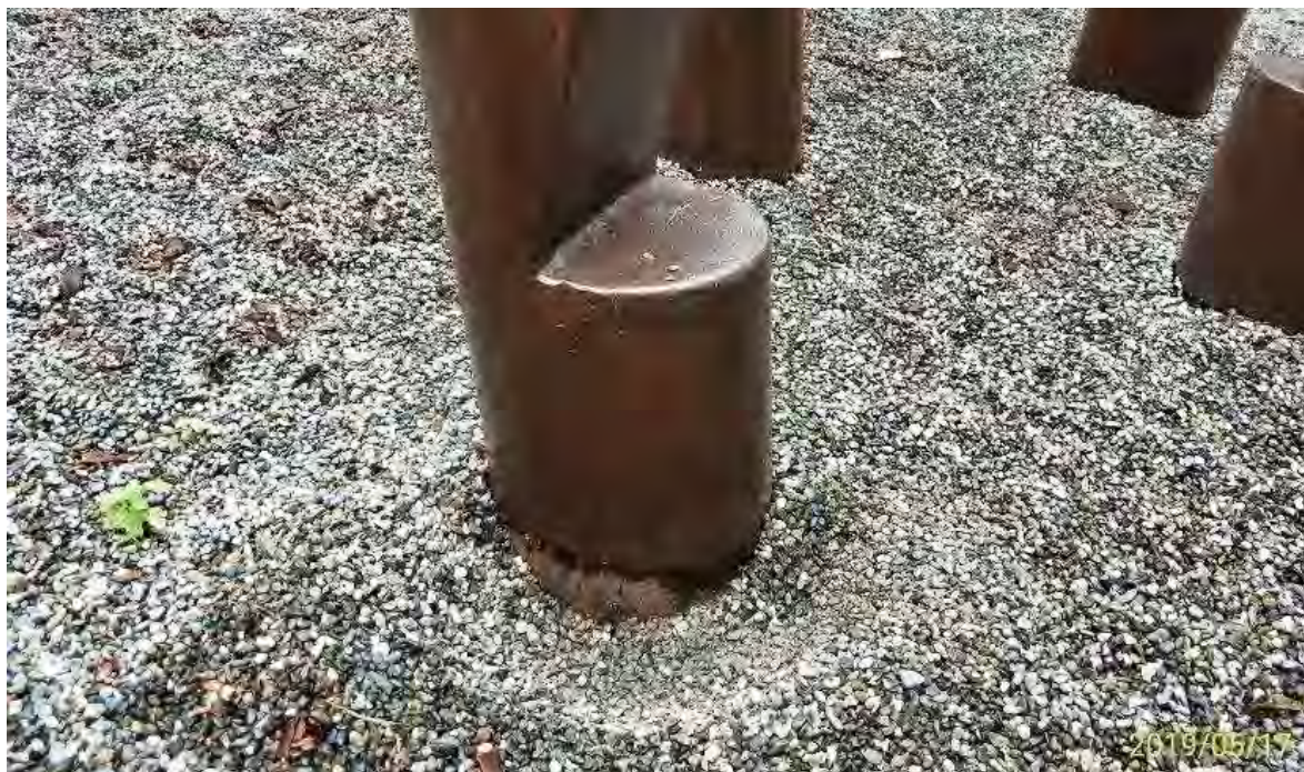
兒童木造遊憩設備固定方式錯誤未抬高固定態樣
