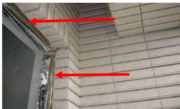
窗框上緣及側邊以木壓條控制塞水路間距
