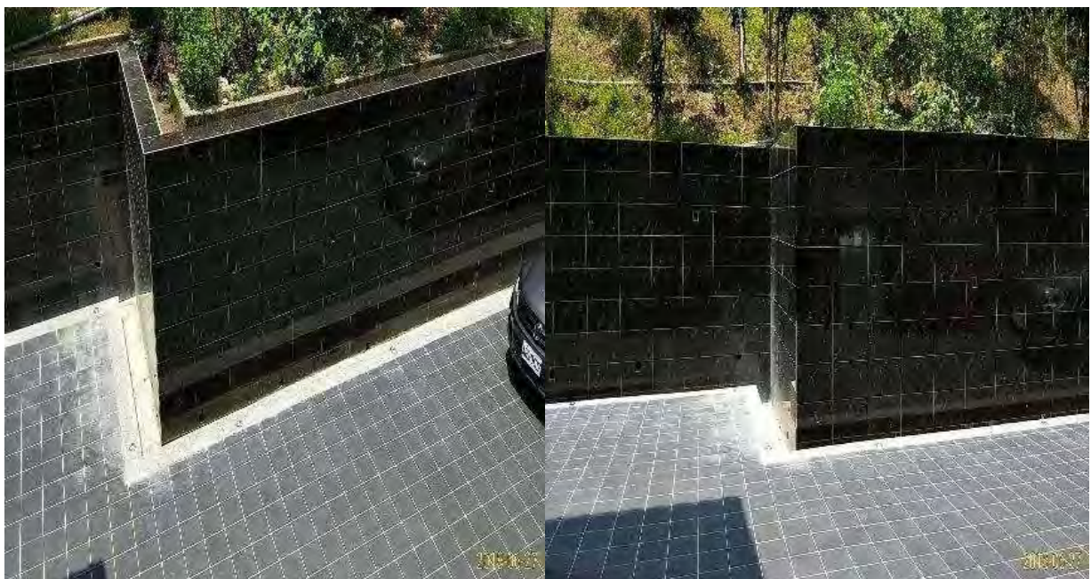
RC擋土牆設置透水管.上下截水溝優良案例
