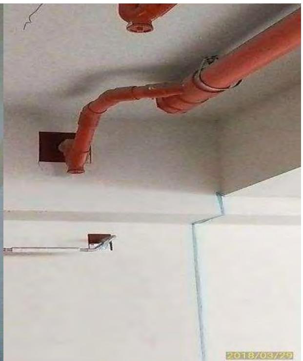
排水管低於主幹管向上銜接會導致逆流阻塞
