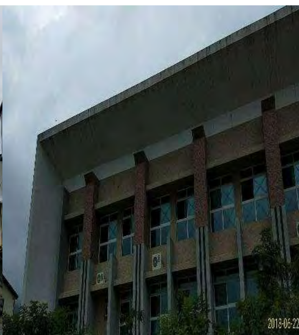
牆簷內斜未考量風雨會導致滲漏也無法以滴水線方式收頭之謬誤
