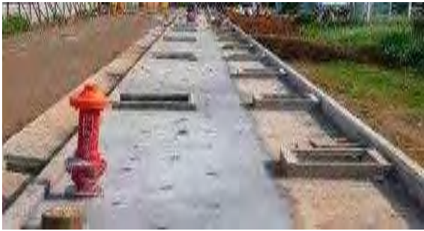
高壓混凝土磚以硬底施工加PVC管透水優良案例
