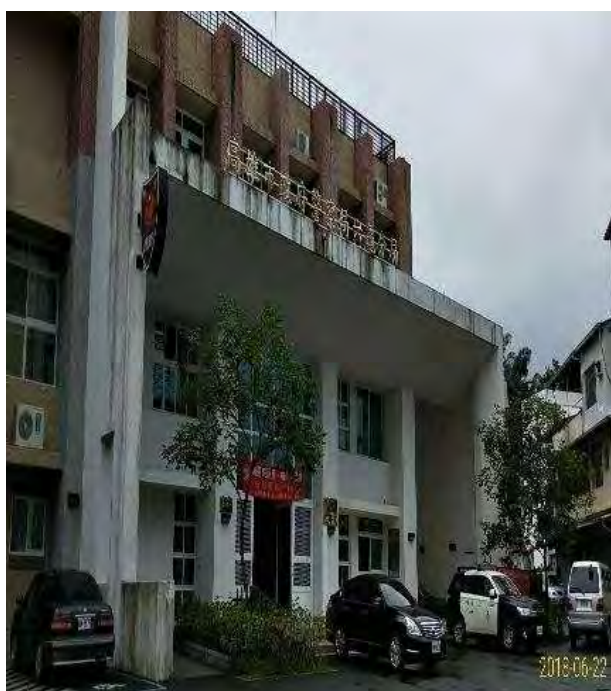
牆簷內斜未考量風雨會導致滲漏也無法以滴水線方式收頭之謬誤
