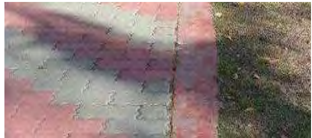
高壓混凝土地面磚周邊砌磚緣石優良做法
