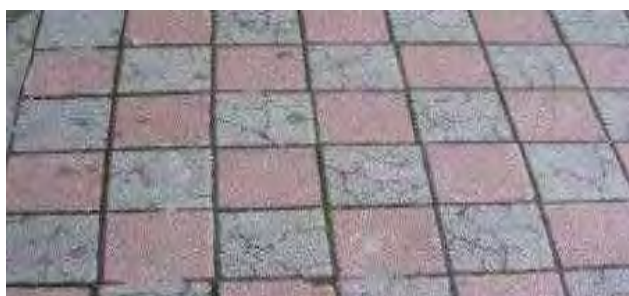
高壓混凝土地面磚龜裂損壞
