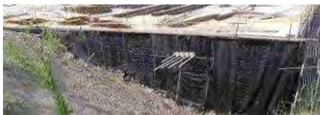
地下室外牆防水材及管線穿越施工不良情形
