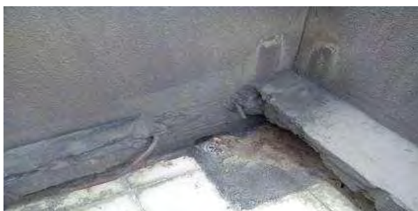
泛水與女兒牆未一體施工之破損實例
