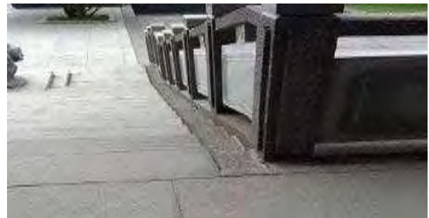
走廊、連通樓梯地坪事先考量導水溝之實例
