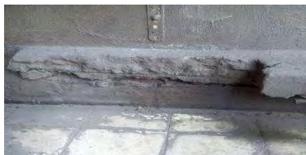
泛水與女兒牆未一體施工之破損實例
