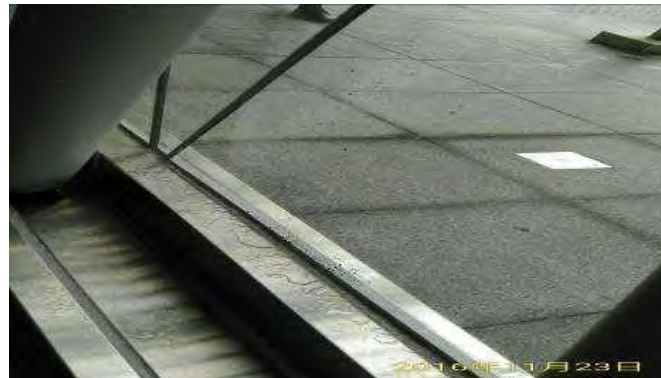
基隆新站弧形玻璃帷幕節點塞水路施工不良遇雨滲漏
