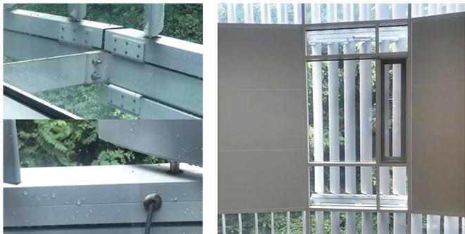
圖2 建築物外部電動百葉構件
