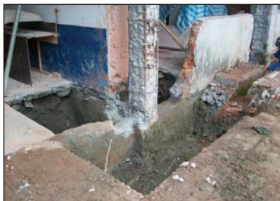
補強處基礎開挖
