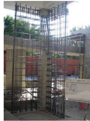
鑽孔植入 牆筋
