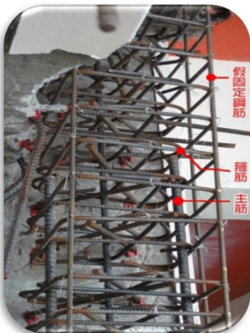
圖3 鋼筋組序施工程序
