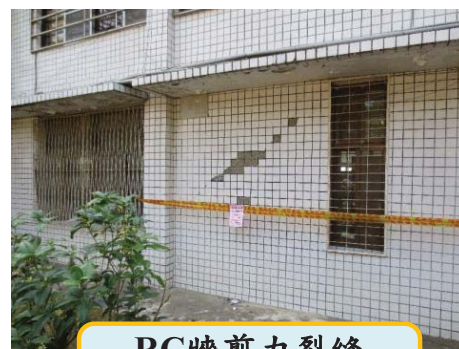
RC牆剪力裂縫 (待補強)
