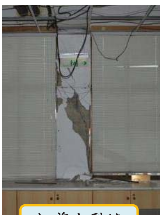
柱剪力裂縫
