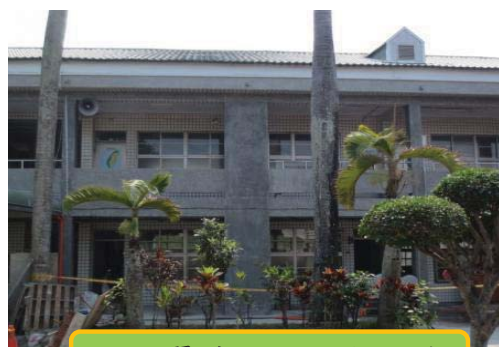
完成翼牆補強，無損壞
