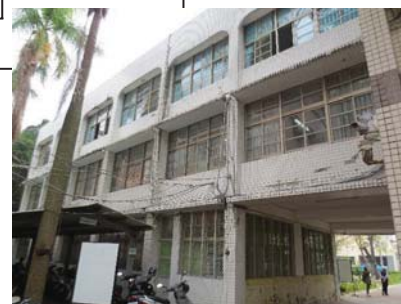
勘災結果：柱發生剪力破壞(一根嚴重破壞，其他柱多處剪力裂縫)
