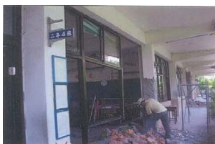
拆除原有門窗
