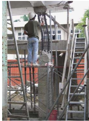
碎裂混凝土 清除
