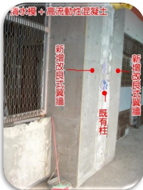
圖4 拆模後之新增改良式翼牆
