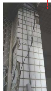
勘災結果：柱發生剪力破壞(一根嚴重破壞，其他柱多處剪力裂縫)
