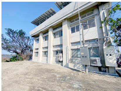
圖12 擴柱完竣之外牆，看不出明顯的施工痕跡(建物右側)
