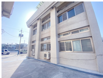
圖13 擴柱完竣之外牆，看不出明顯的施工痕跡(建物左側)，原地下室之通風窗已填實
