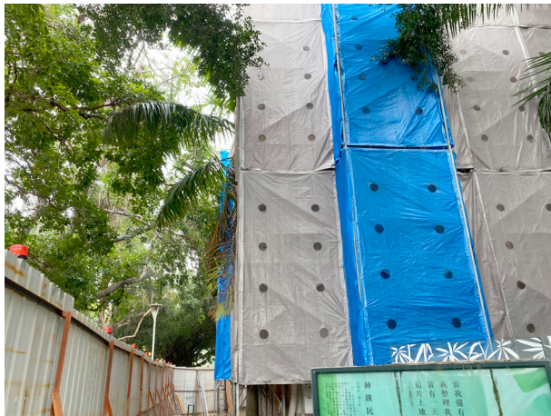
圖4-2 施工架上下設備被覆對比色防塵網方便逃生
