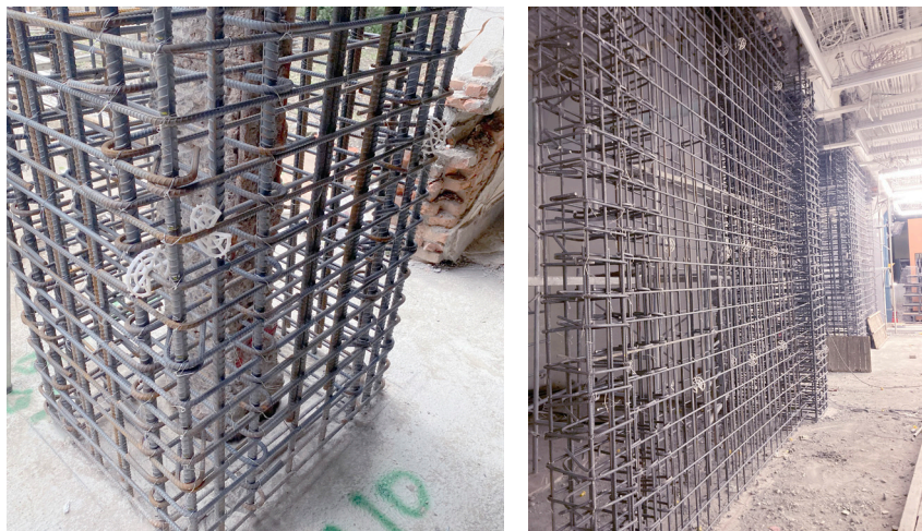
圖3-3 補強元件1. 擴柱（左）2. RC牆（右）
