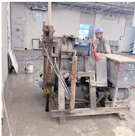
圖3-4 微地盤改良灌注1. 工法示意圖（左）2. 現場灌注（右）
