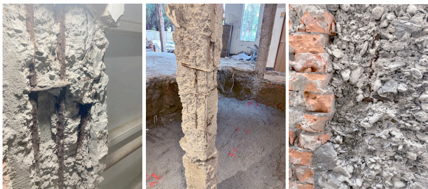
圖2-3 現場打除後發現梁柱牆構件原施工品質不佳
