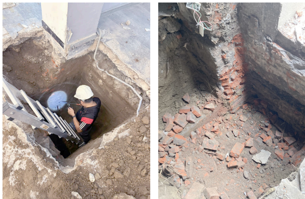
圖2-2 施工前再次試挖確認基礎形式及深度分佈
