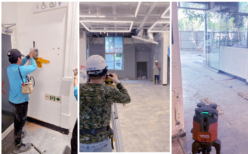
圖4-1 施工中監控, 傾度盤設置 (左) 2. 水準測量 (中) 3. 雷射水平儀 (右)
