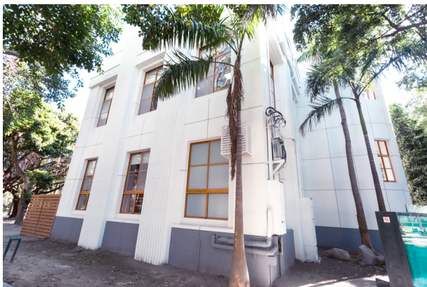
圖5-1 外牆施作防水層及仿石塗料杜絕滲水並搭配木紋氣密窗
