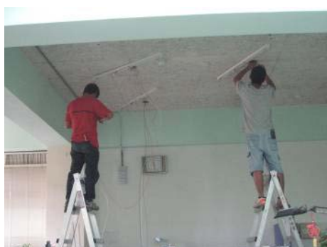
圖 17 全面更換本館電源線及管線
