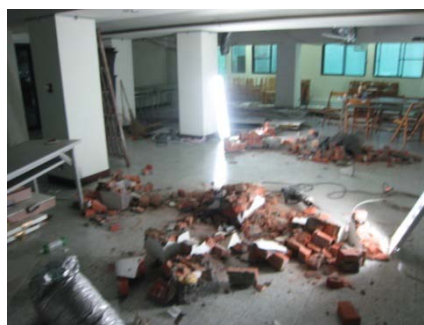
圖 6 進行打除作業
