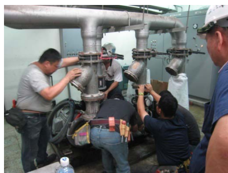
圖 10 辦理水線安全移位工項
