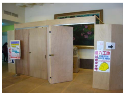
圖 5 架設安全圍籬
