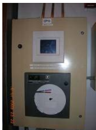
圖 10-6. 溫濕度控管記錄器。
