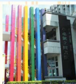
南投縣草屯鎮立圖書館外觀 改善後照片
