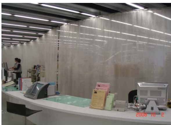
懸吊式透明塑膠布隔間
