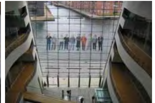
6M 高，2.4M 寬的玻璃牆承重量高，需由特殊桿件懸吊固定。
