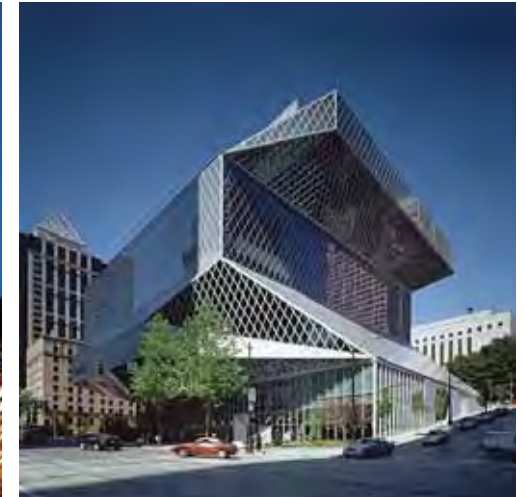
鋼構與玻璃結合的西雅圖圖書館
