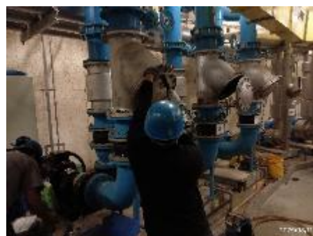
圖 236 機水電設備保養
